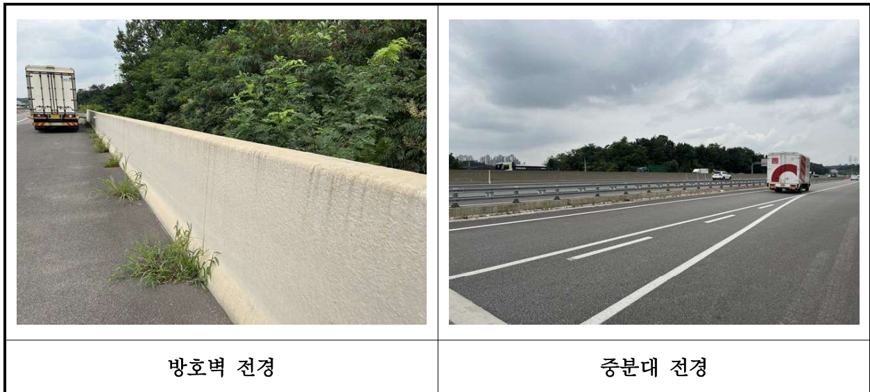
【사진 24.3.23】 방호벽 및 중앙분리대 전경
