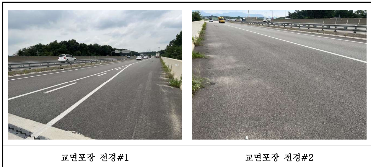
【사진 24.3.19】 교면포장 전경
