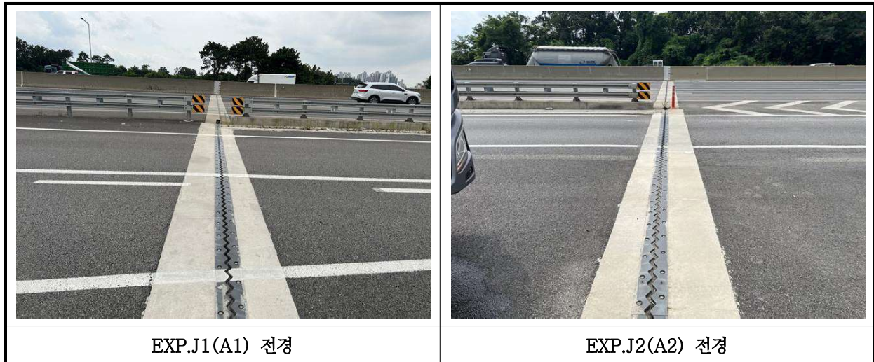
【사진 24.3.16】 신축이음장치 전경
