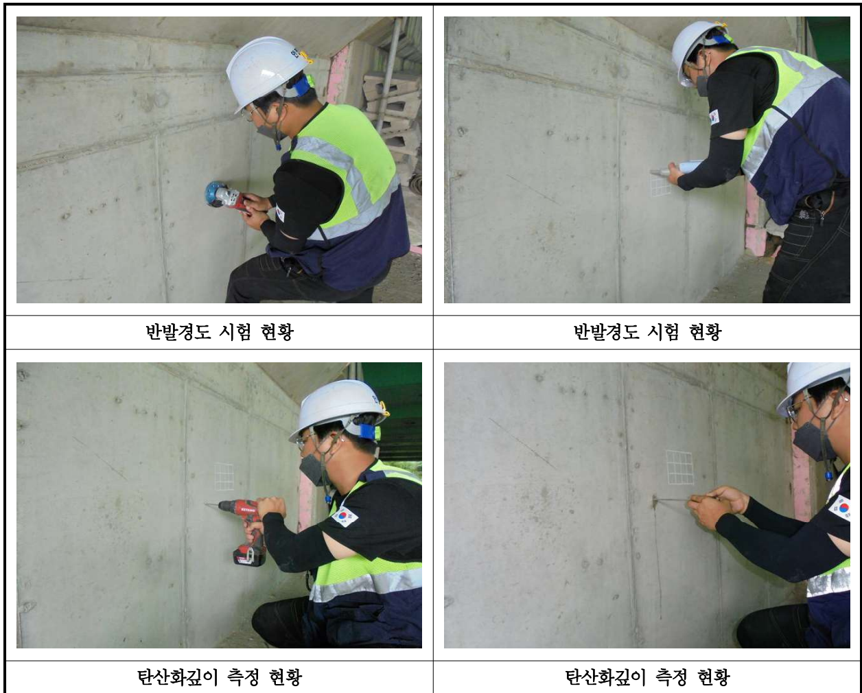
【사진 24.4.1】 콘크리트 내구성조사 현황
