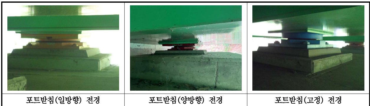
【사진 24.3.12】 교량받침 전경
