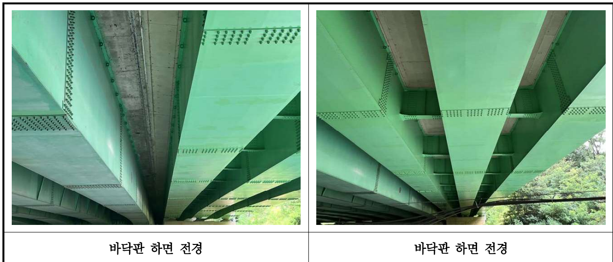
【사진 24.3.2】 바닥판하면 전경
