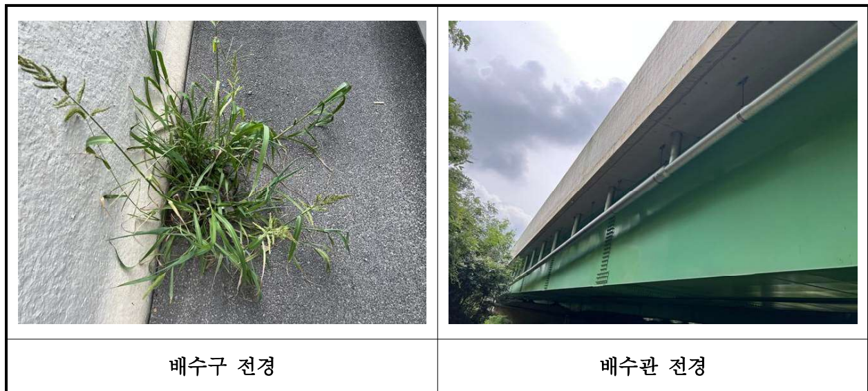
【사진 24.3.21】 배수시설 전경
