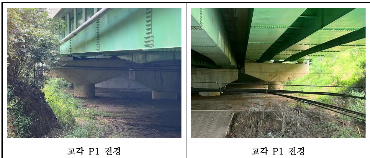
【사진 2.3.10】 교각 전경
