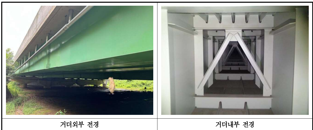
【사진 24.3.4】 거더 전경
