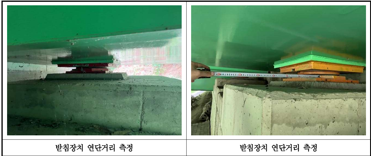
【사진 24.3.14】 교량받침장치 연단거리측정
